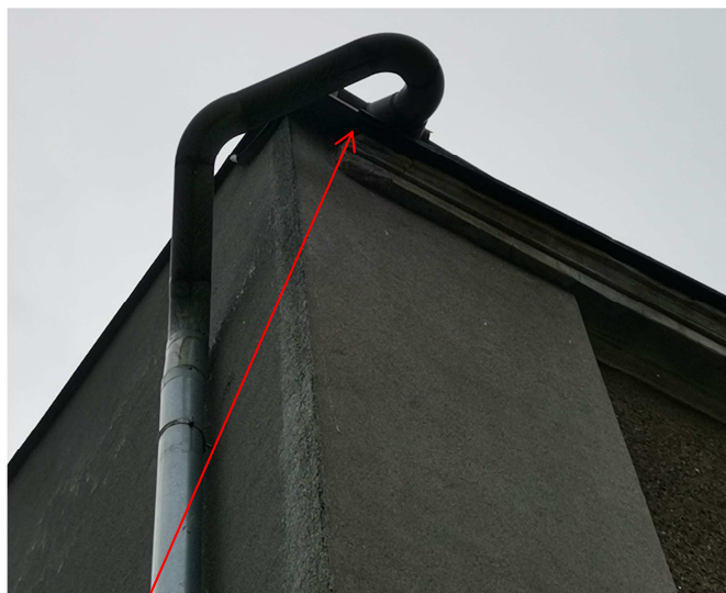
neestetické odvodnění nástřešního žlabu uliční fasády
